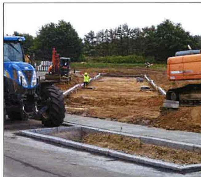
Det første spadestik var lidt snyd, for håndværkerne var allerede godt i gang med at lave det første fundament. Håndværkerne gik i gang samme dag, som byggetilladelsen kom i hus.
