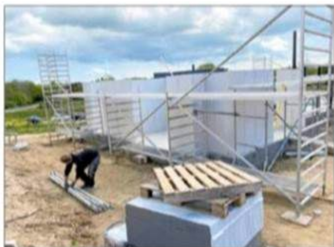
Håndværkerne er som det sidste gået gang i med fælleshuset.
